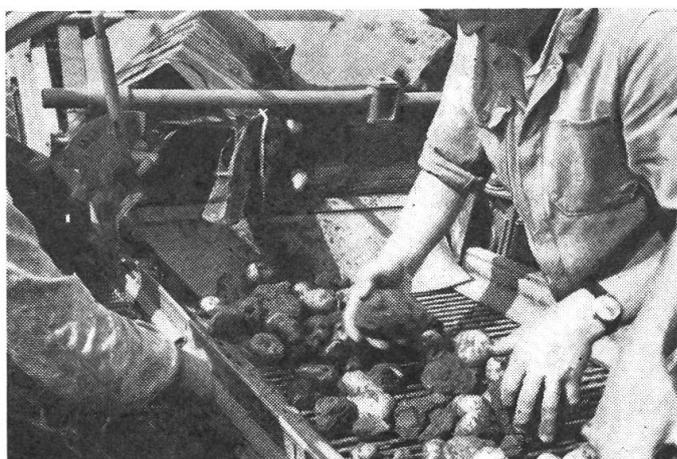
Abb. 3: Der Anteil an Erdschollen, die bei der Vollernte von Hand auszulesen sind, ist bei geringer Reihenweite (66 cm) grösser, als bei Breitreihen (75 cm).
