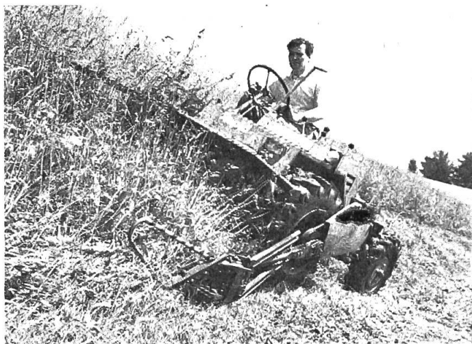
Abb. 9: Eine neue hangspezifische Arbeitsmaschine, die mit dem Mähwerk und einem Heuer ausgestattet werden kann.
