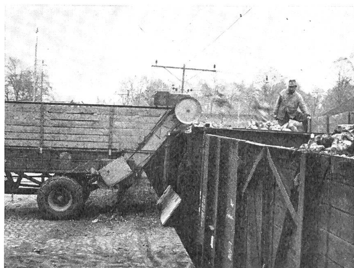
Abb. 5: Vielzweckwagen beim Rübenverlad auf Normalrampe.
