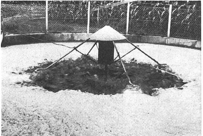
Abb. 2: Oberflächenkreisel mit Schwimmgerüst.
