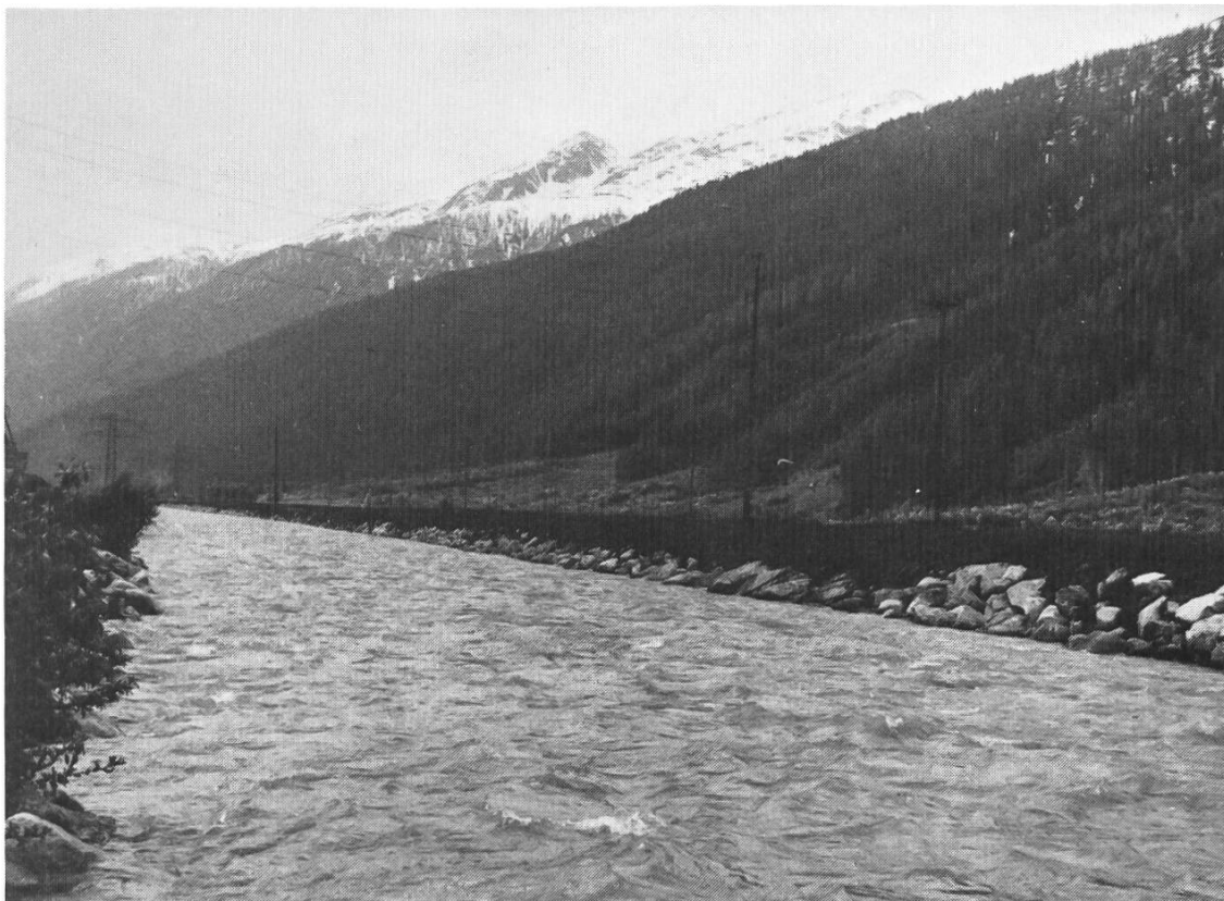
Zerstörung einer naturnahen Flusslandschaft: Verbauung mit durchgehendem Trapezprofil. Der lebendige Fluss wird zum monotonen Kanal. Rotten bei Oberwald (VS)
