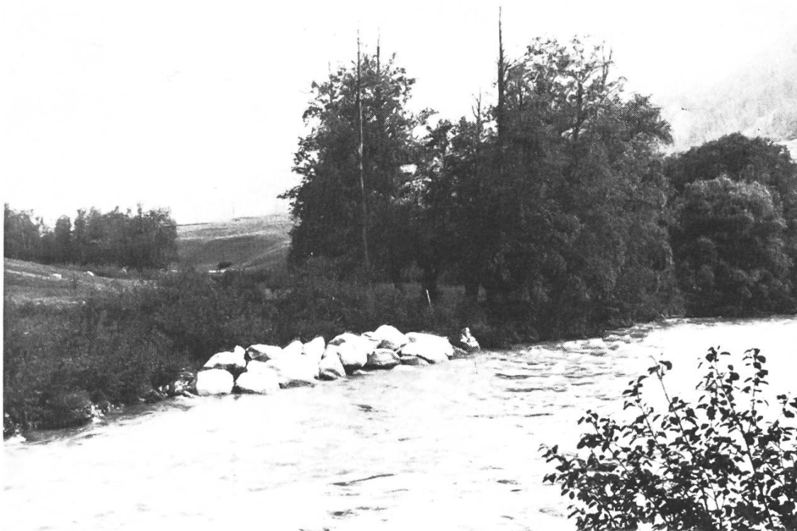
Vorbildliche Lösung: Beschränkung auf das notwendige Minimum, Sanierung einer Anrissstelle mittels Blockwurf. Flachufer und Ufervegetation bleiben erhalten. Rotten bei Münster (VS)
