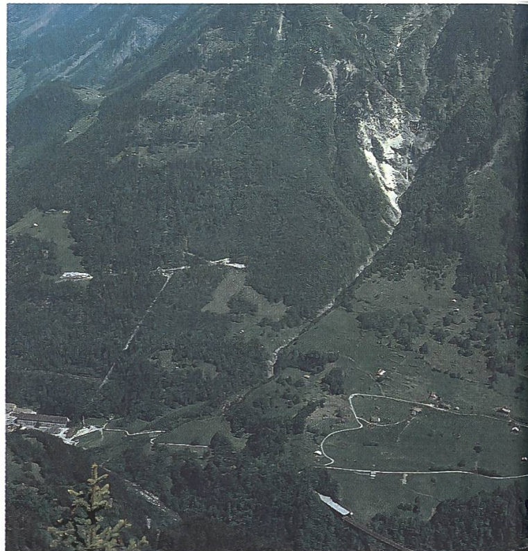
Nordwestansicht der Bristenlauri in Amsteg UR. Aufnahmen vor den Lawinenabgängen 1999
