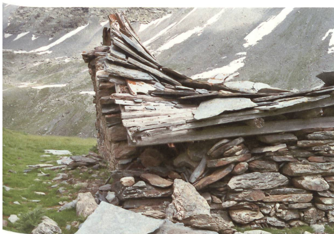
Die Schutzhütte Vouasse in der «Combe de l'A» in Liddes VS vor der Sanierung
