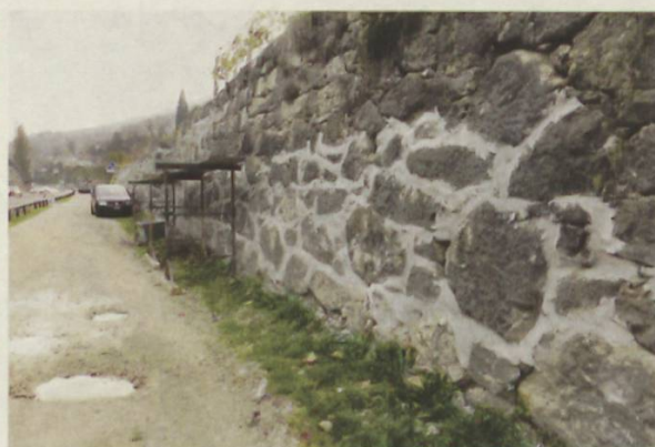
Halbseitig ist die Sanierung der Trockenmauer an der Neuenburgstrasse. Nun geht es aber vorerst nicht weiter.
