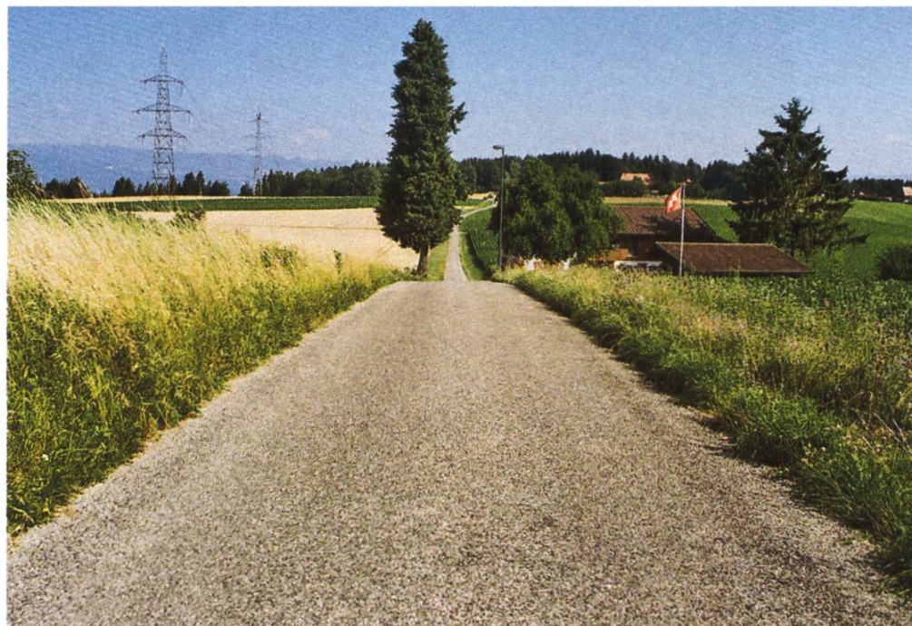
Illegale und unnötige Apshaltierung von Wanderwegen in Seedorf BE
