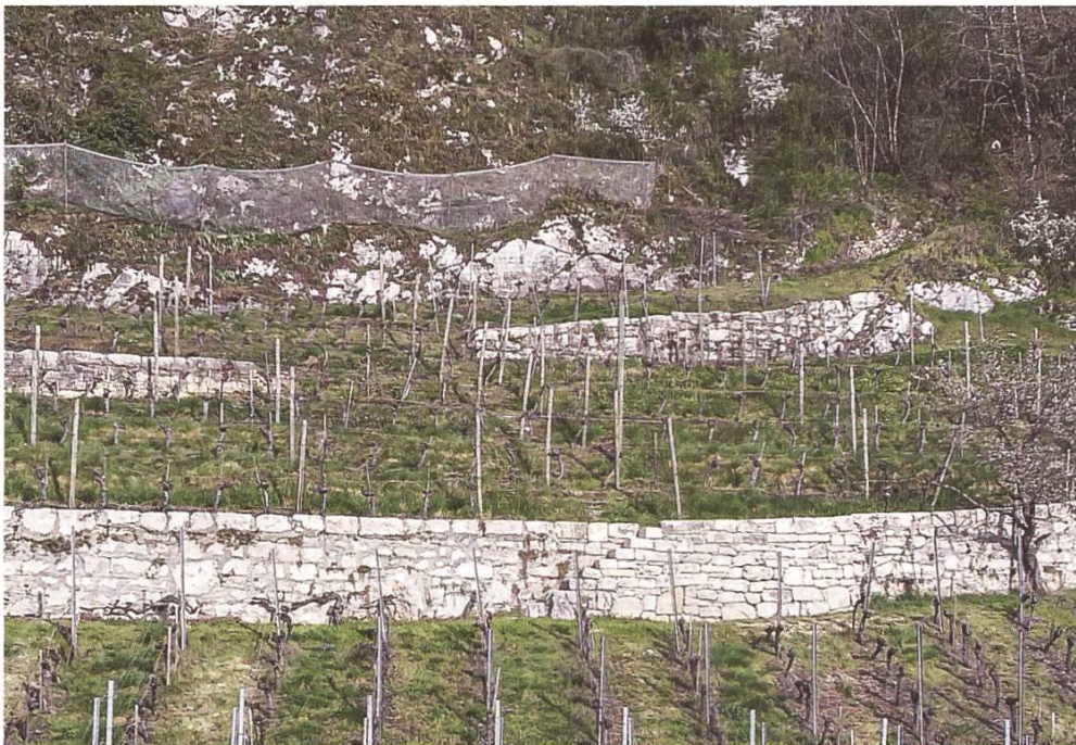
Die restaurierte Trockenmauer ob Chly Twann
