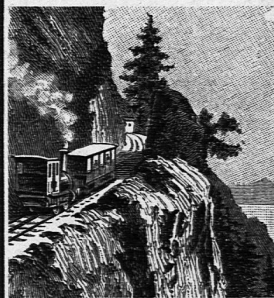
Kräbelwand Partie der Arth-Rigi-Bahn
