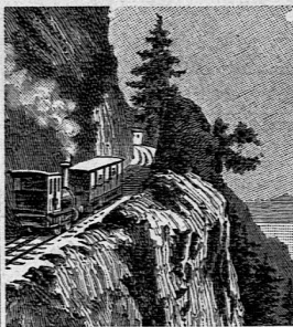
Kräbelwand Partie der Arth-Rigi-Bahn
