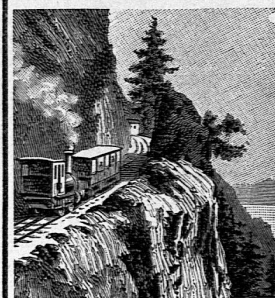
Kräbelwand Partie der Arth-Rigi-Bahn
