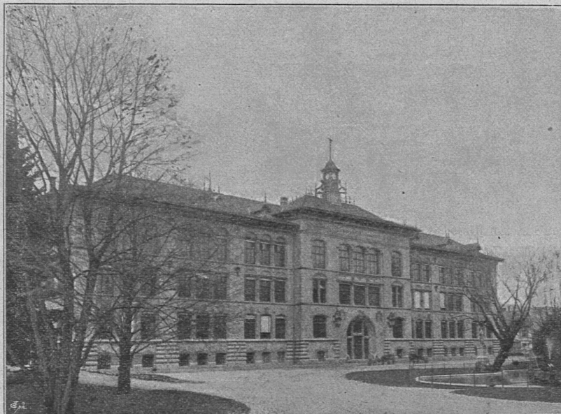
Das neue Kantonsschulgebäude in Aarau.
