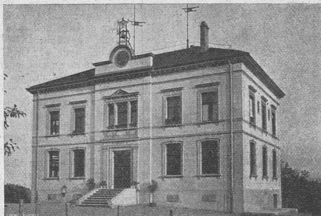
Neues Schulhaus Hohentannen.
