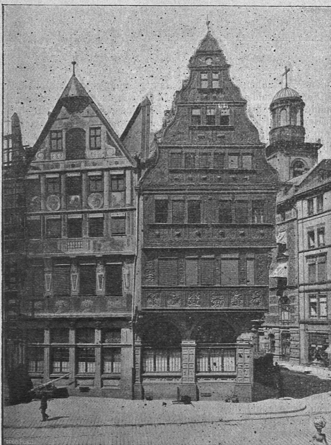
Frankfurt a. M., alte Häuser am Römer.
