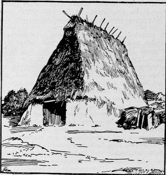
Abbild. 1. Die Dachhütte.
