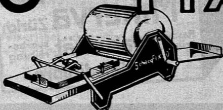
heißt der neueste Rotations-Vervielfältiger, der es ermöglicht, dass ganze Stapel Papier zum Druck aufgelegt werden können, der das Papier vollkommen selbsttätig zuführt, bedruckt und wieder ablegt und mit dem jedermann mühelos in der Stunde ca. 3000 Abzüge von Hand-, Maschinenschrift, Noten, Zeichnungen etc. herstellen kann. — Trotz alledem ist der Apparat viel billiger als ähnliche, bisher bekannte.
