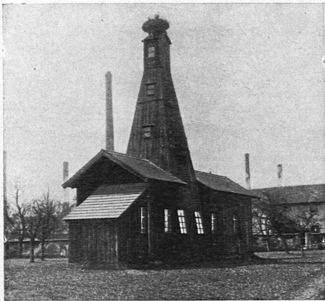
Bohrturm; dahinter die Hochkamine der Saline.
