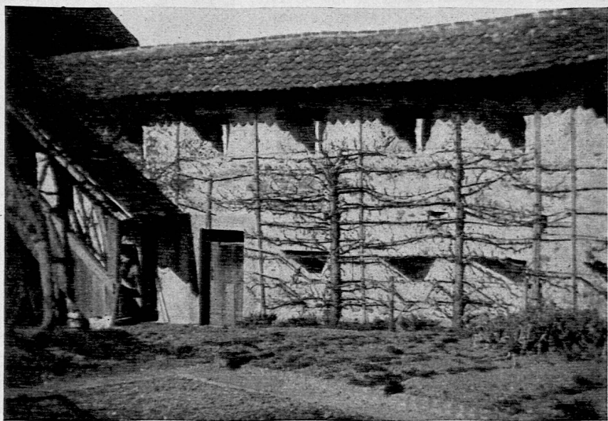
Zwingmauer zwischen Käfigturm und heutiger Schlossterrasse. Zwischen den zwei Reihen Schiesscharten sind die Balkenlöcher des ehemaligen Wehrgangs sichtbar
