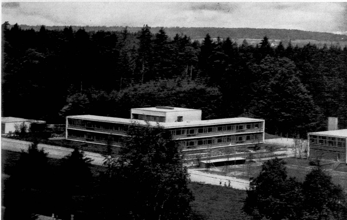
Schulhaus Hürstholz im Schulkreis Zürich-Glattal
