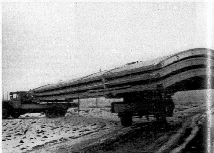
Transport rostförmig verleimter Sheddach-Elemente
