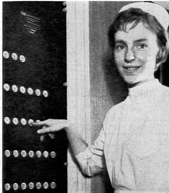
CMC-Sicherungsautomaten sind jederzeit betriebsbereit und Schalter und Sicherung zugleich
