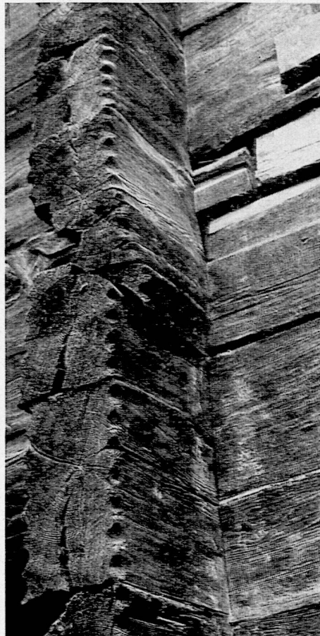
Vorstehende Balkenwand aus vierkantig behauenen Lärchenholz an einem Blockbau in Evolena (Val d'Hérens) im Wallis.
