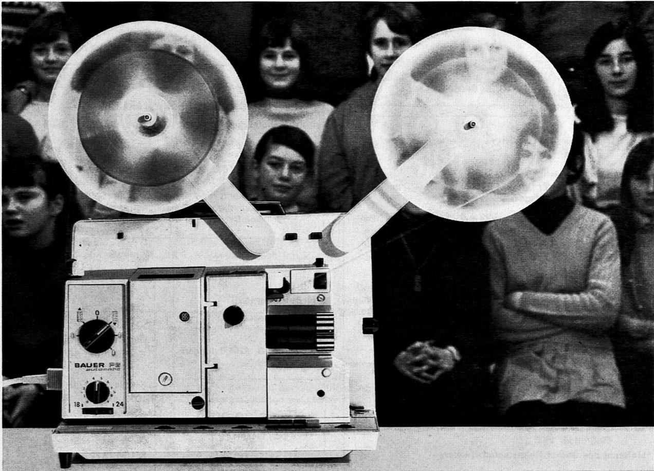
**1** Den P6 können Sie überall einsetzen. Von der kleinen Schulstube bis zum grossen Saal. Seine Lichtleistung überzeugt auch den Zuschauer auf dem hintersten Platz. Und das Bild wird nicht nach einigen Vorstellungen dunkler, weil sich die Lampe schwärzt. Der P6 hat eine Halogen-Lampe, die von der ersten bis zur letzten Stunde hell leuchtet. 50% heller und 300% länger als gewöhnliche Lampen.
