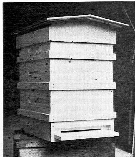
*Einheitsbeute* aus Tannenholz. Die Konstruktion ist sehr einfach. Den Besitz einer Kreissäge vorausgesetzt, lässt sich dieser Kasten gut im Handfertigkeitsunterricht herstellen. Die Baupläne können bezogen werden bei K. von Gunten, 3652 Hilterfingen.
