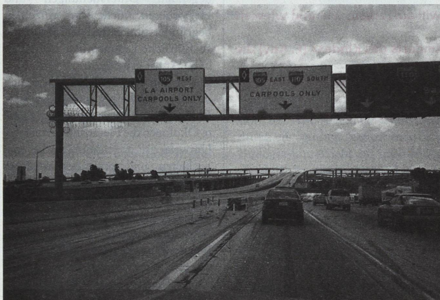
In Amerika gibt es in vielen Grossstädten separate Fahrspuren für Fahrgemeinschaften (carpools). In Los Angeles wurde sogar eine 9-stöckige Autobahnkreuzung gebaut, damit die reservierten Fahrspuren in allen Richtungen separat miteinander verbunden sind (im Hintergrund des Bildes).
