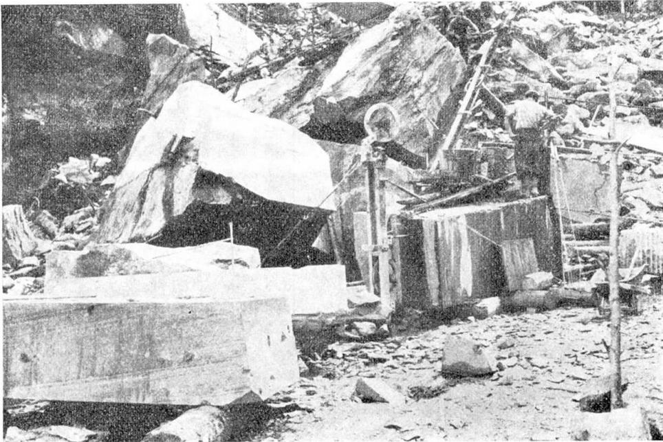
Fig. 2. Zersägen der Serpentinblöcke im Steinbruch mit Stahldrahtsägen.
