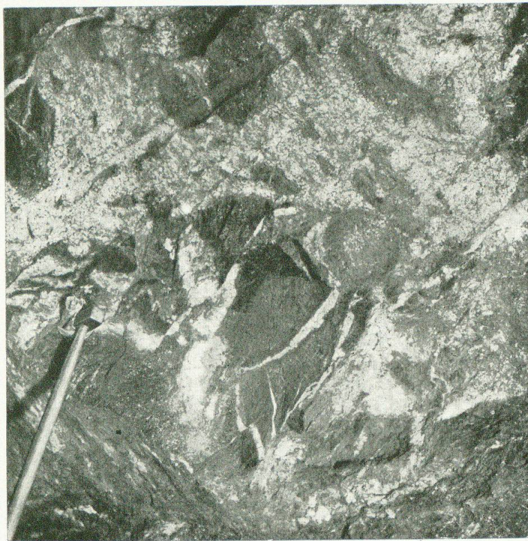
Abb. 4. Innertkirchnergranit, porphyrtig, mit Aplitadern (hell) und Amphibolitschollen (dunkel) durchsetzt. — Stollen Schaftelen nach Steinwasser, m 880 (First).
