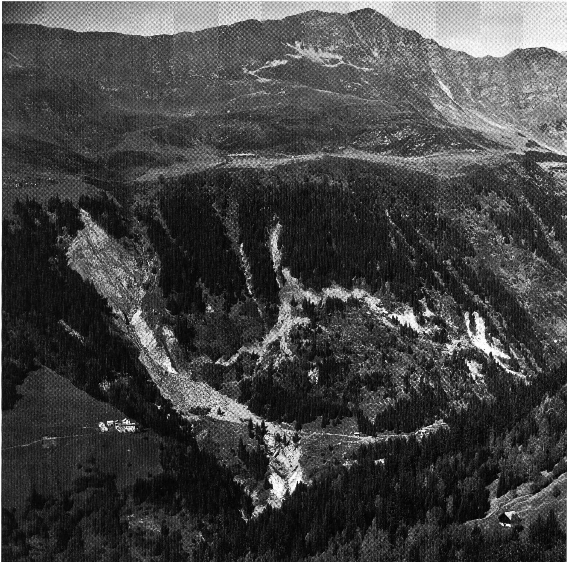
Foto 1: Panoramica del versante destro della Canaria all'altezza di Rùtan dei Sassi. Il nucleo di case di Monti occupa parte del pascolo sulla sinistra (a valle rispetto alla frana). La fessura perimetrale appare come una banda bianca piuttosto sfilacciata. Sulla sinistra si nota il grande affioramento roccioso di forma romboedrica dovuto alla frana del Riale delle Fontanelle. Al centro dell'immagine, verso il basso, è ben visibile l'intaglio prodotto dal Rì di Monti durante l'alluvione del 1993. Sul tutto troneggia il Giübin (2776.4 m). La fotografia è stata scattata da Rùtan (1615 m) nel mese di ottobre 1994. Foto di Roberto Buzzini.
