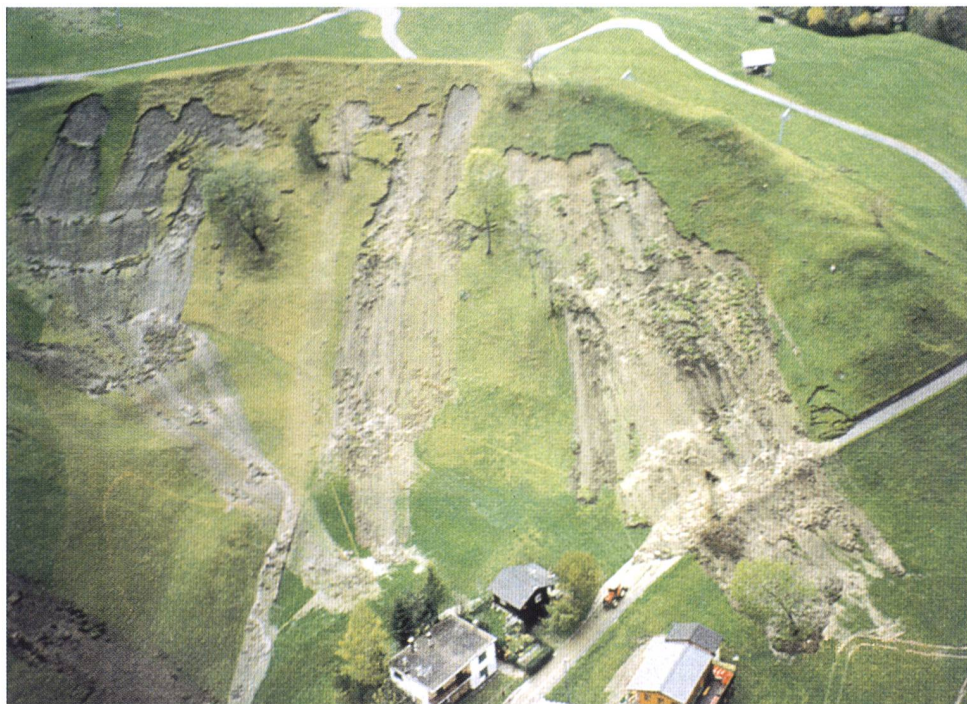
Fig. 1 – Frane superficiali a Campo Blenio dovute all'evento alluvionale del 1993.
