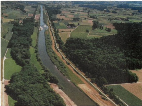
Die Thur bei Niederneunforn-Altikon TG vor der Sanierung im Jahr 2000: Der Fluss ist begradigt, liegt in einem künstlichen Schotterbett und die Ufer sind mit mächtigen Steinblöcken verbaut. Der Auenwald auf der rechten Flussseite ist vom fließenden Wasser getrennt (Blickrichtung flussabwärts).
