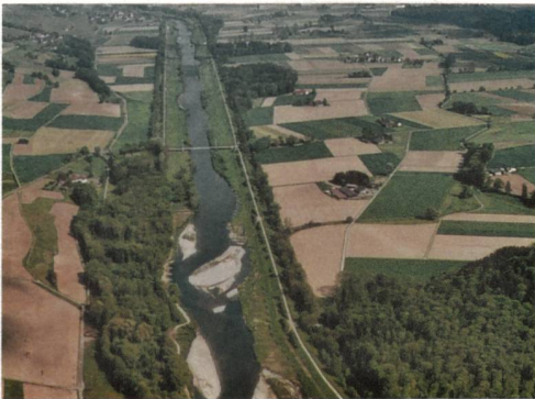
Die Thur bei Niederneunforn-Altikon nach der Sanierung im Jahr 2004: Kies- und Sandbänke hat sich die Thur schon beim ersten Hochwasser selber geschaffen, Auen und Altläufe sind an die Wasserführung des Flusses angeschlossen. Damit entstand neuer Lebensraum für Biber & Co.
