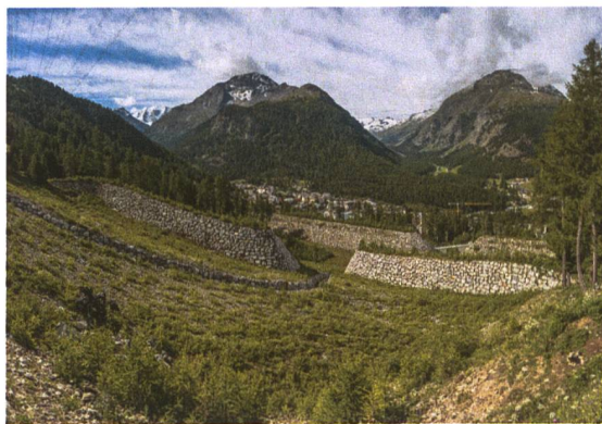
Pontresina, GR: Weil der Permafrost am Schafberg oberhalb von Pontresina auftaut, ist die Wahrscheinlichkeit niedergehender Murgänge stark gestiegen. Dies machte den Bau hoher Dämme und eines riesigen Auffangbeckens notwendig. Seit 2003 schützen diese Kunstbauten die Ortschaft.
