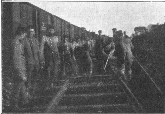
Deutsche Kriegseisenbahn. Erstellung eines Geleises. Chemin de fer de campagne allemand; pose d'une voie.
