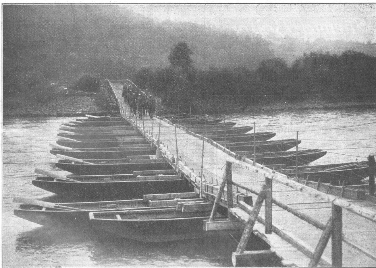
Schiffbrücke. — Pont flottant construit par nos pontonniers.
