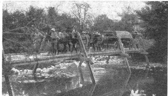
Bau einer Bockbrücke aus Ordonnanz-Material. Construction d'un pont de chevalets avec du matériel d'ordonnance.
