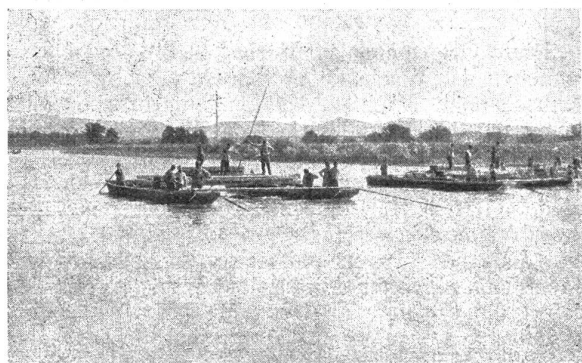
Zerlegen einer Pontonbrücke in einzelne Glieder.
