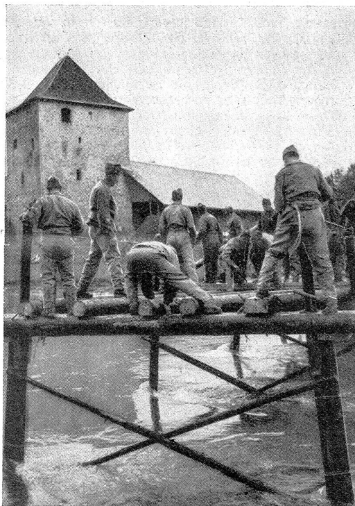
Beim Einsetzen des Tragbalkens Le placement des poutres
