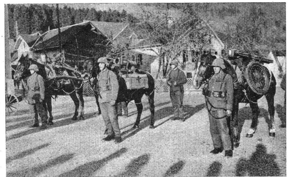
Fig. 4. Le canon de 47 mm démonté et bâti. Parallèlement au tube sur le cheval de droite (no. 1) on remarque deux leviers de bois employés pour faciliter le chargement des charges supérieures.
