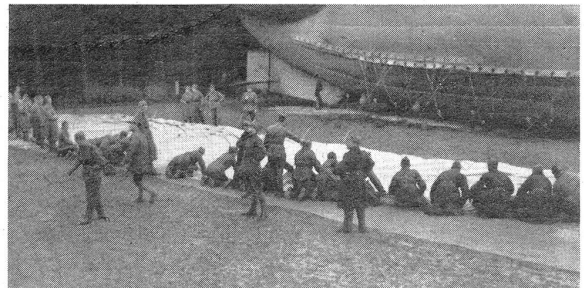
Falten eines Fessel-Ballons; im Hintergrund kamp. Motor-Ballon. Pliage d'un ballon captif. Dans le fond un ballon à moteur campé.
