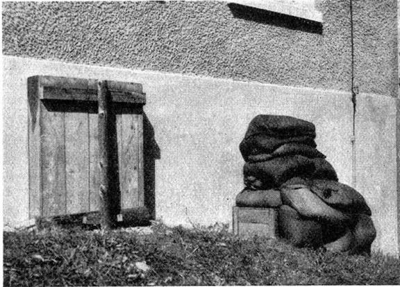
Passiver Luftschutz. Luftschutz-Raum. Die äußere Abdichtung der für Luftschutzräume vorgesehenen Keller erfolgt entweder durch eine starke Auflage von Sand- und Erdesäcken (Fenster rechts) oder aber durch einen Holzverschlag von mindestens 50 cm Tiefe, der mit fest zusammengestampfter Erde ausgefüllt wird (Fenster links).
