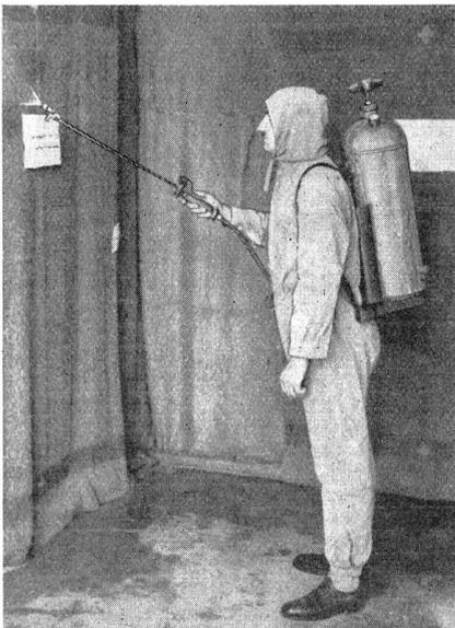
Passiver Luftschutz. Luftschutz-Raum. Abspritzen und entgiften in einer Gaschleuse mittels einer Chlorkalklösung.
