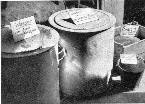
Passiver Luftschutz. Luftschutz-Raum. Der Luftschutz-Vorraum hält für die Benutzer des Schutzraumes Behälter für vergiftete Kleider, Wasser zum Löschen und Entgiften, Sand zum Löschen, Feuereimer und Chlorkalklösung zum Desinfizieren bereit.
