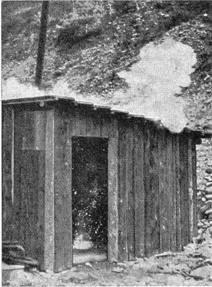
**Passiver Luftschutz. Versuche mit Brandbomben.** Eine Elektron-Brandbombe hat eingeschlagen, durch die offene Tür ist der entstehende Brandherd gut sichtbar; durch das Dach entweichen starke Rauchwolken.
