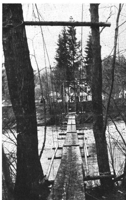
Arbeiten unserer Genietruppen. — Fertiger Hängesteg. Phot. Hohl, Arch. Travaux de nos troupes du génie. — Passerelle suspendue. I lavori delle nostre truppe del genio. — Passaggio sospeso ultimato.
