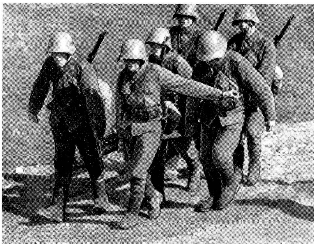
Bautrupps beim Transport eines schweren U-Stahlbalkens zum Einsatz in eine größere Tanksperrung.
