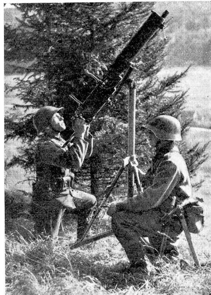
Für die Nahabwehr feindlicher Flugzeuge verfügt die Grenzschutzkompanie über Maschinengewehre mit Kreisvisier und Speziallafette. Phot. K. Egli, Zürich.
