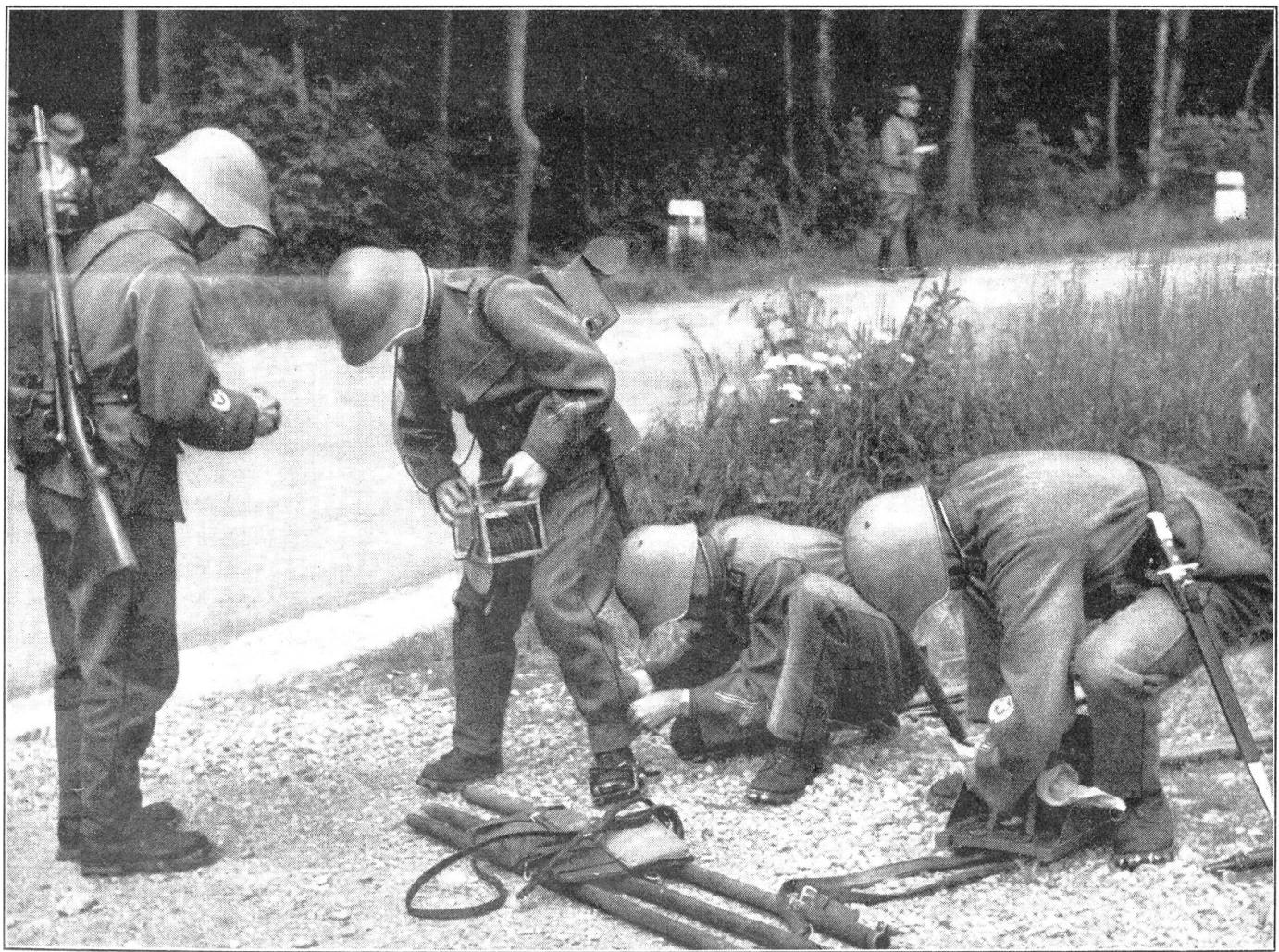
SUT 1937 in Luzern. Wettkünften der Telephon-Patrouillen. Eine Telephon-Patrouille beim Ausrüsten mit dem zur Verfügung stehenden Baumaterial. Dem zweiten Manne von links wird eben von einem Kameraden der Erdschuh angeschnallt, mittels welchem der Trupp auch während des Linienbaues jederzeit von der Anfangsstation angerufen werden kann.
