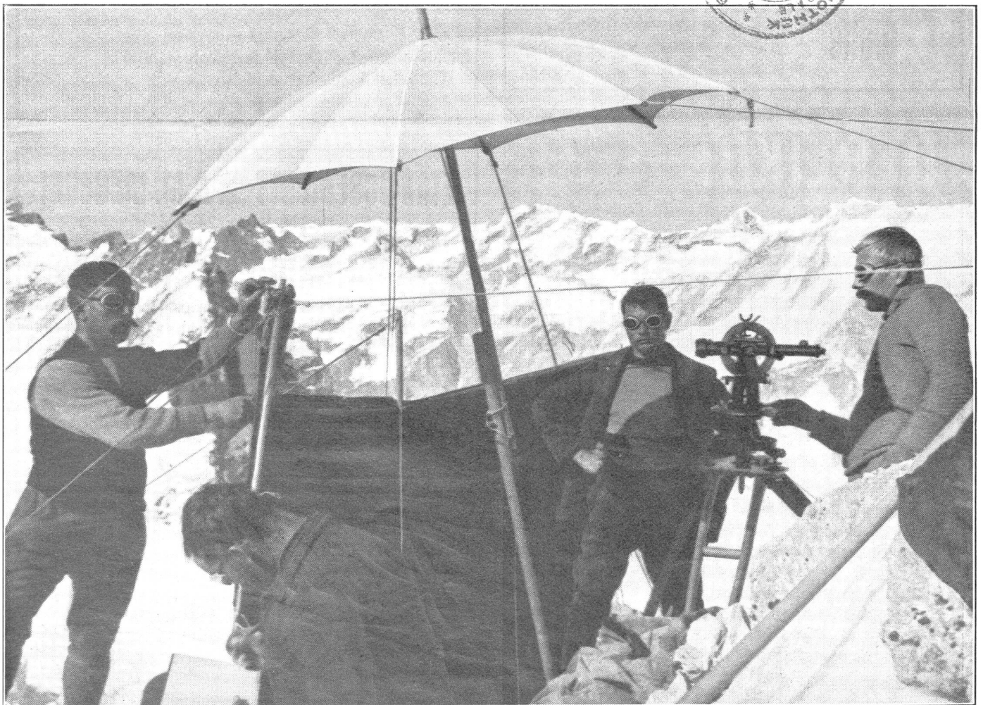
Vom Entstehen unserer Landkarten. Trigonometer bei Winkelmessungen auf der Cima della Bondasca (3293 m ü. M.). Travaux préparatoires pour l'établissement de nos cartes topographiques. Mesures d'angles sur la Cima della Bondasca (3293 m. au-dessus de la mer).
