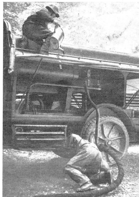
Auto-Kompressor und Auto-Röhrenwagen ermöglichen, einen Mineurzug in kürzester Zeit auch auf größere Entfernungen zu Bohr- und Sprengarbeiten anzusetzen.
