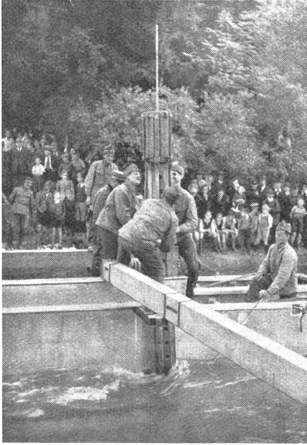
Einbau eines Bockes vom Ponton aus. Die Bockfüße werden mit einer Handramme leicht eingerammt.
