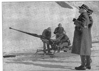
Links: Zwillingss-Fliegerabwehr-Maschinengewehr mit Zielfernrohr zur Abwehr von Tiefangriffen. (VIB 1175.) A gauche: Mitr. D.C.A. jumelle avec dioptré pour le tir contre des avions volant bas. A sinistra: Mitragliatrice antiaerea a canne gemelle, con cannocchia, per difendersi dagli attacchi a bassa quota.
